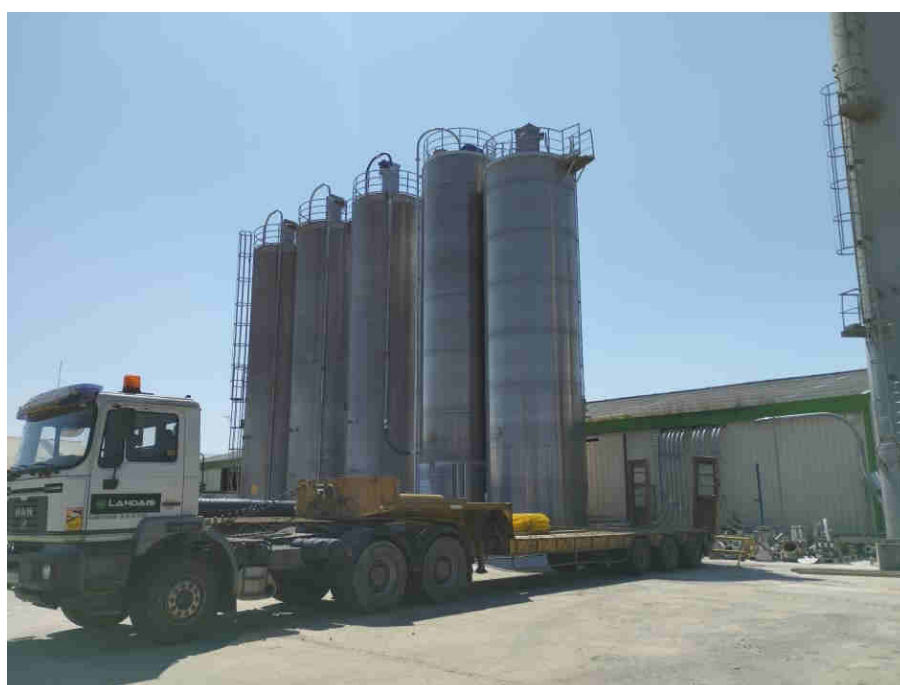
Figure 19 : Silos de stockage des matières premières en vrac
