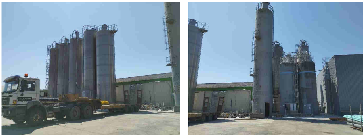
Figure 13 : Photos des silos
